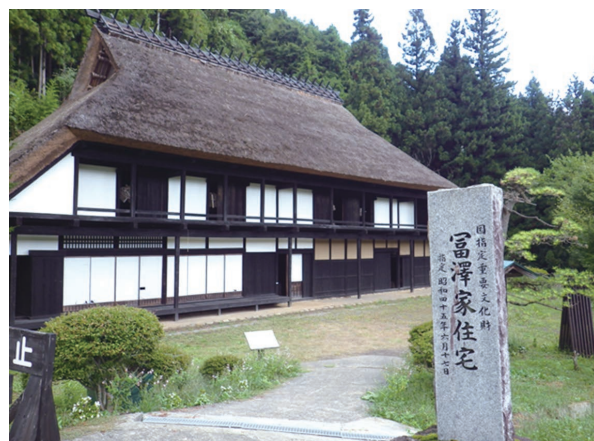
図6 18世紀末に建てられた大型の養蚕農家 群馬県中之条町大道 1274 富沢家住宅
